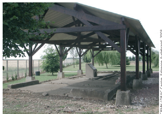
Fondations de la baraque des bains-douches.
